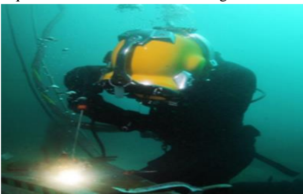
Fig: 2. Actual underwater welding technique.
